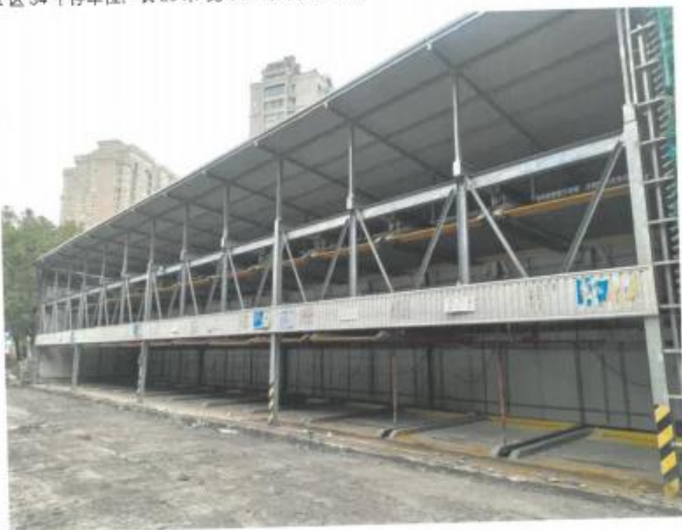
1区 34个停车位, 长 20米*宽 6.05米*高 5.75米
