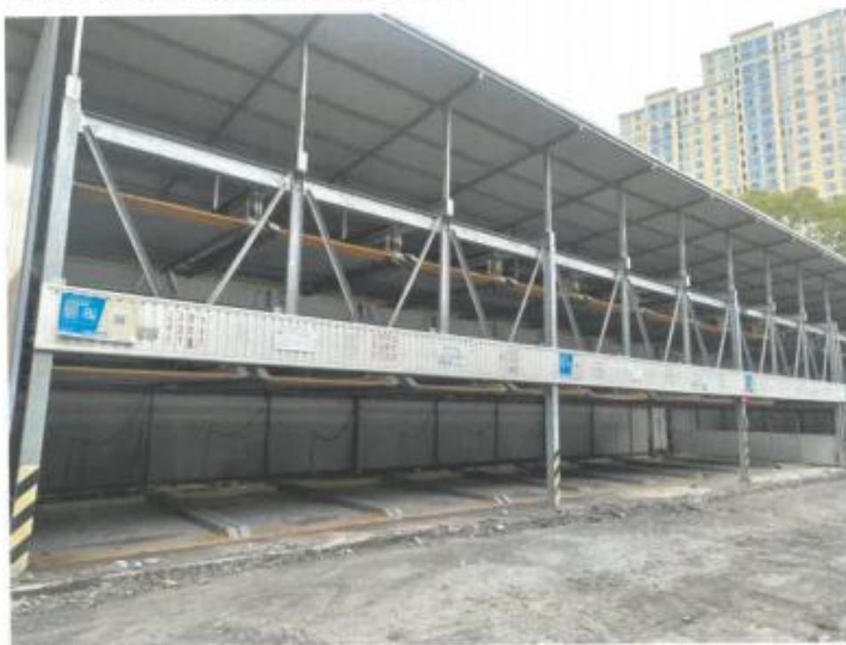
3区 25个停车位, 长20米*宽6.05米*高5.75米
