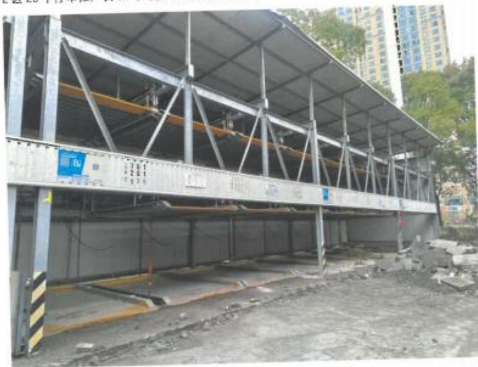
2区 25个停车位, 长 35米*宽 6.05米*高 5.75米
