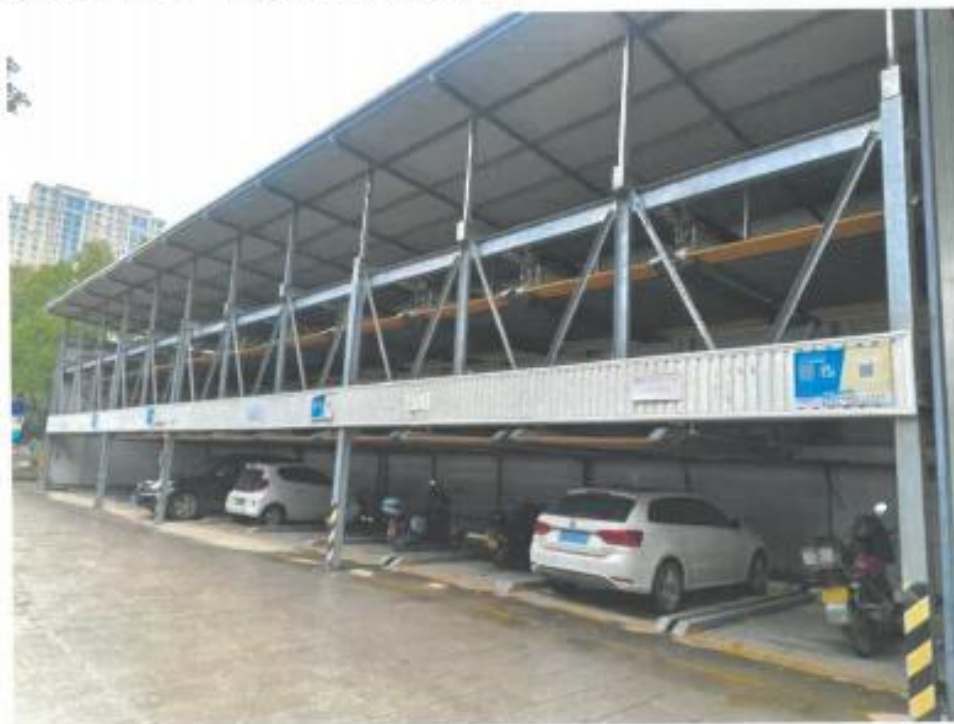
4区 31个停车位, 长27.5米*宽6.05米*高5.75米
